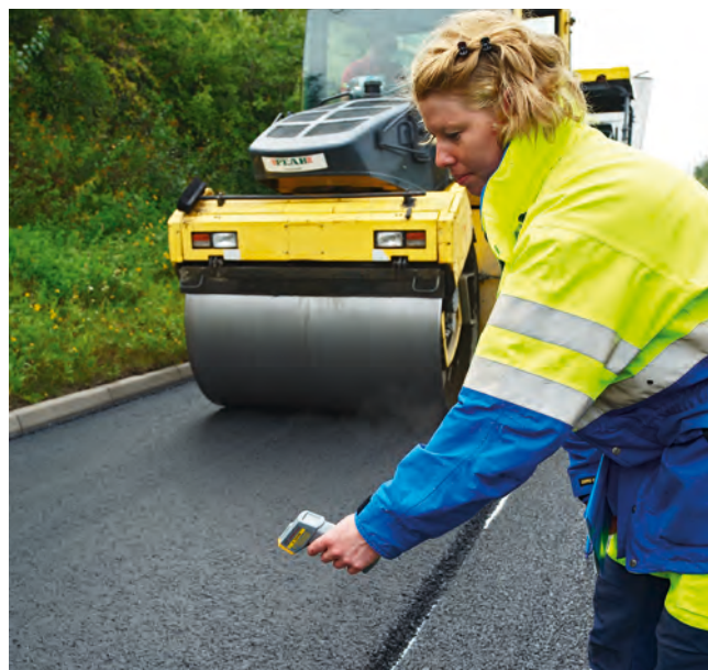
Kontroll av temperaturen på asfaltbeläggningen.
